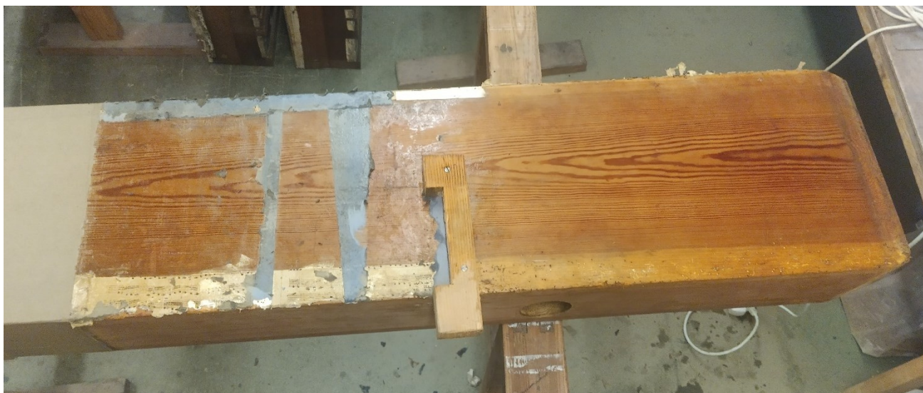
Vzduchovod v průběhu čištění, snímání několika vrstev papíru
