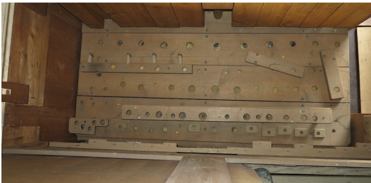
Horní pohled na nepřívodní vzdušnici
