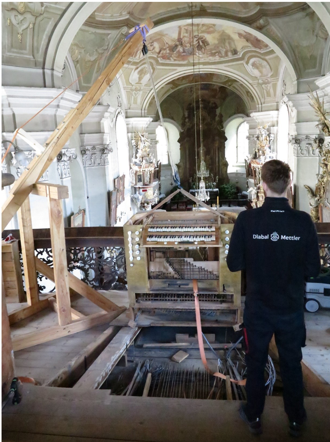
Demontáž varhanního stolu
