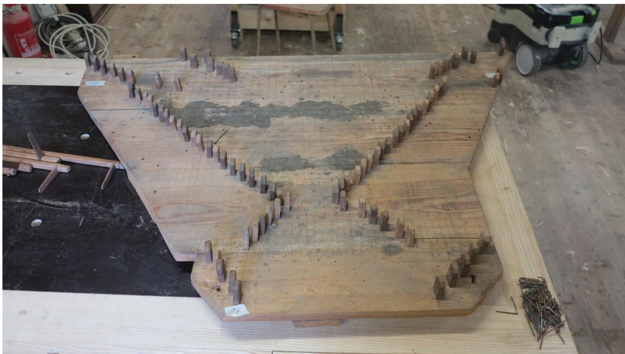
Hřidelová deska pozitivu – demontáž
